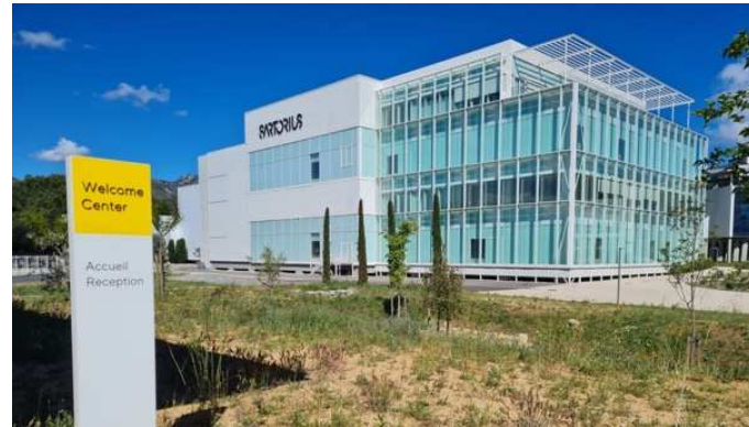
Bâtiment de production
