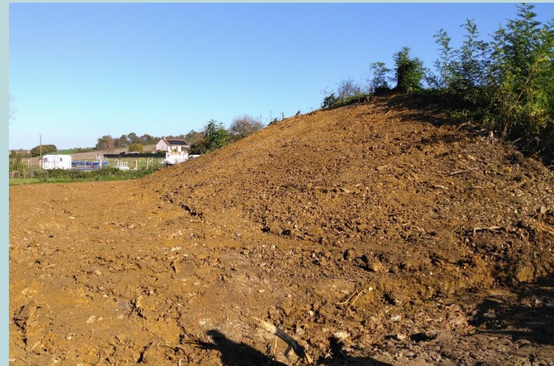
↑ Arasement de la digue d'Ougney, novembre 2024
