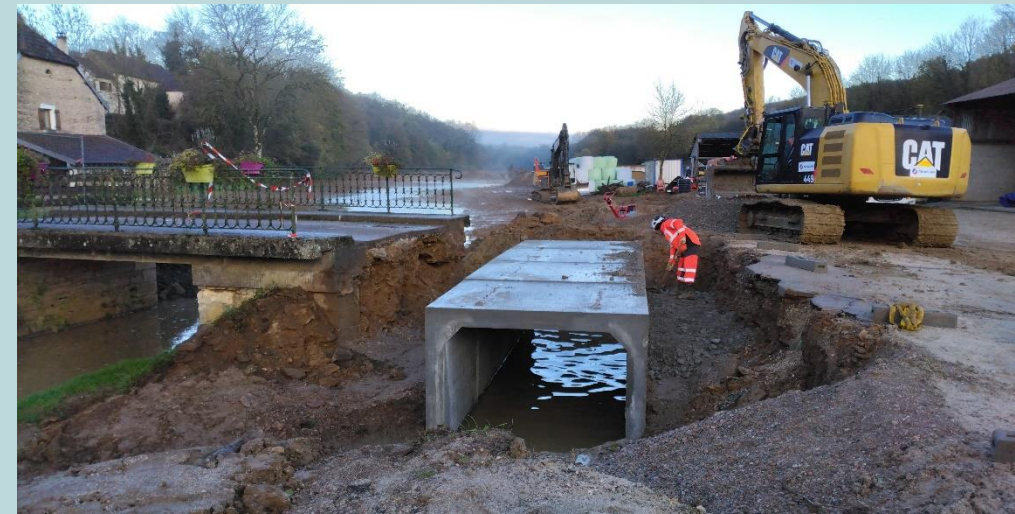
↑ Pose du dalot, novembre 2024
