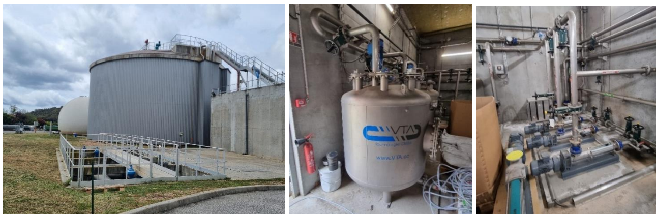
Photos – STEU de Campo dell'Oro – Gauche : digesteur – 2 photos de droite : procédé par sonolyse
