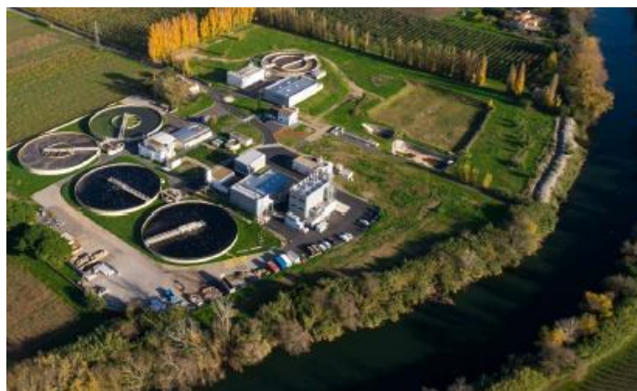
Vue aérienne de la station de Béziers
