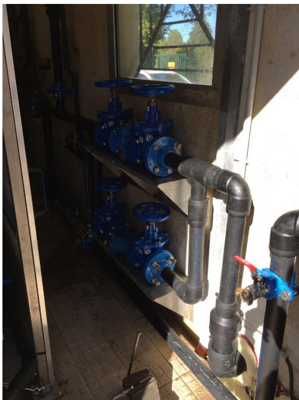
Tuyauterie pour amener l'eau au filtre bande - Fontvieille (gauche) et unité de surpression - Fontvieille (droite)
