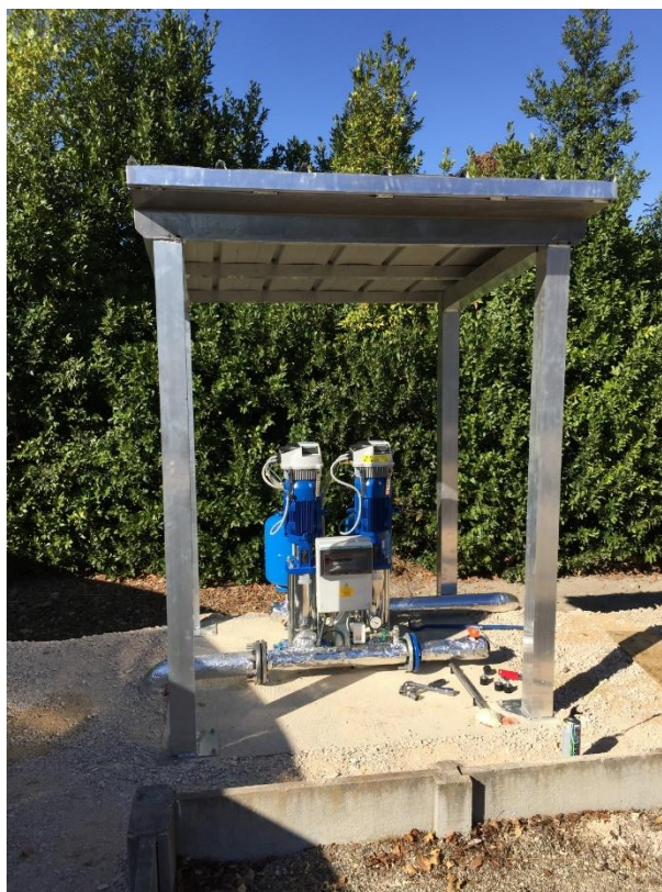
Tuyauterie pour amener l'eau au filtre bande - Fontvieille (gauche) et unité de surpression - Fontvieille (droite)
